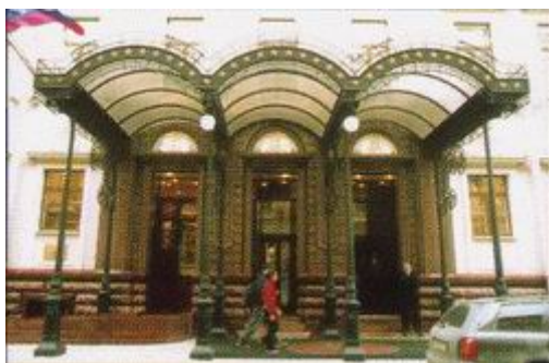
Гостиничный комплекс в г. Санкт-Петербург ООО «Ренессанс Санкт-Петербург Отель Лизинг» ул. Почтамтская, д. 4, лит. А.
